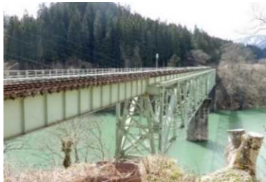
第二只見川橋梁（三島町）
