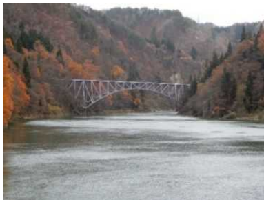
第一只見川橋梁（三島町）
